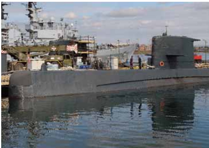
Cantiere navale a Taranto
